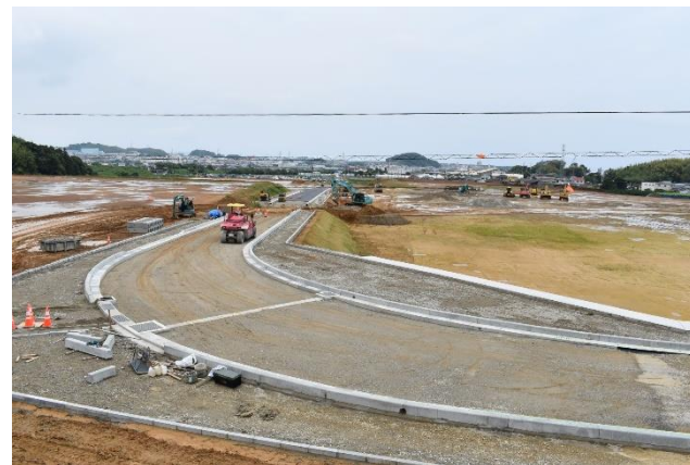
造成工事中新原高木地区
