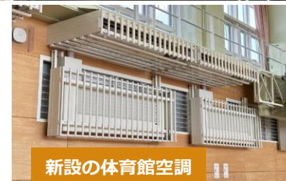
改修された体育館（東中）
