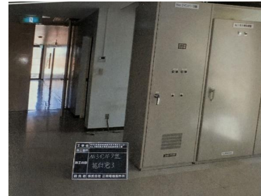
古賀水再生センターNo.3遠心脱水機電気設備更新工事
