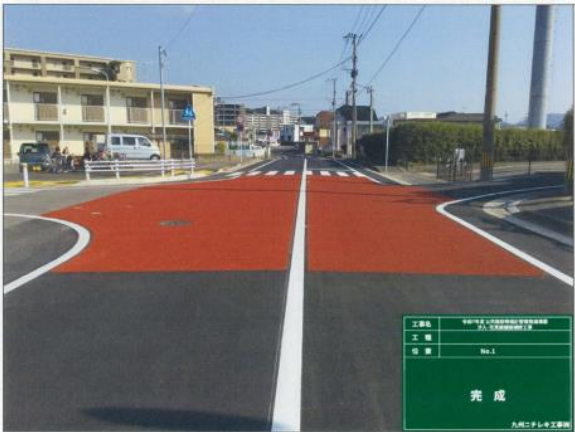
道路舗装補修工事（汐入花見線）
