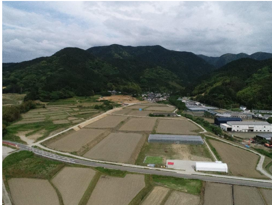
1工区工事完了、2工区施工中の状況
