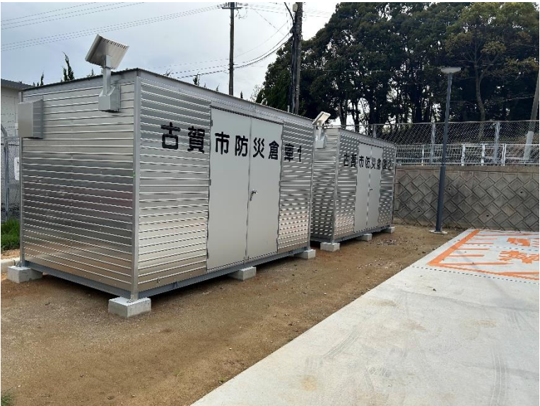
古賀東中学校防災倉庫
