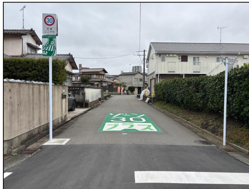
整備後（路面標示や速度規制看板を整備した古賀西小校区周辺）
