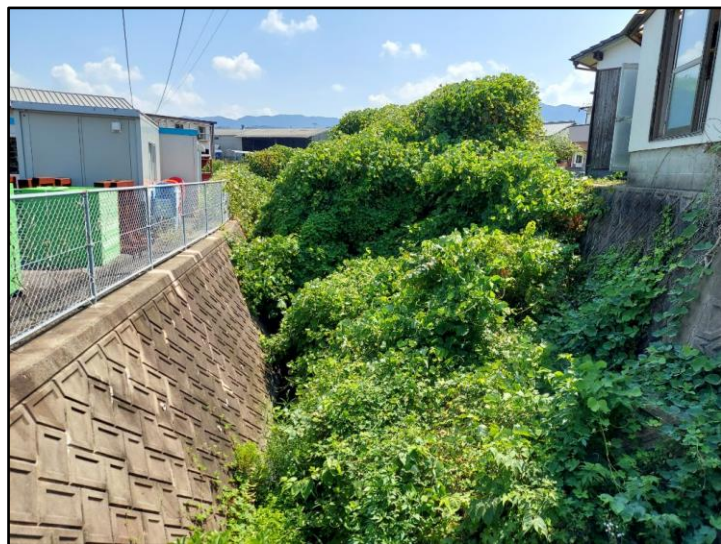
浚渫前（町川原川）
