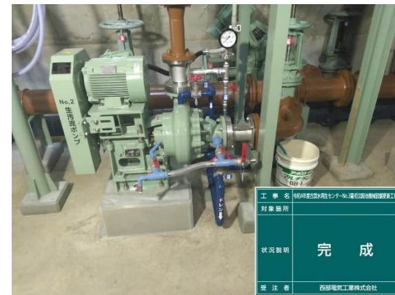
古賀水再生センターNo.3最初沈殿池機械設備更新工事
