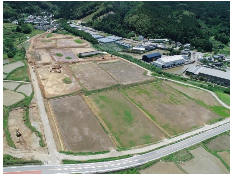
1工区施工中の状況
