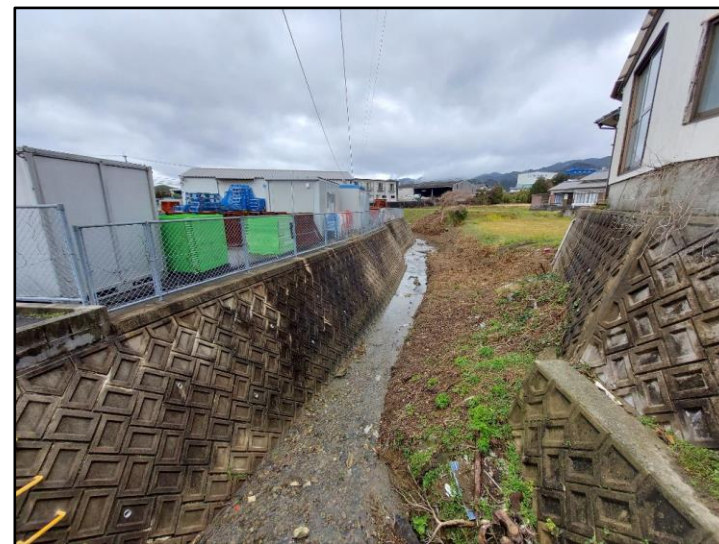
浚渫後（町川原川）
