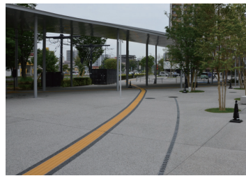
無彩色の舗装を使用した場合に視覚障がい者誘導用ブロックの輝度比を確保する工夫の例
