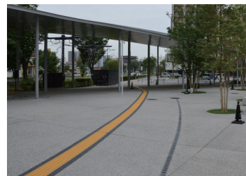
無彩色の舗装を使用した場合に誘導用ブロックの輝度比を確保する工夫の例
