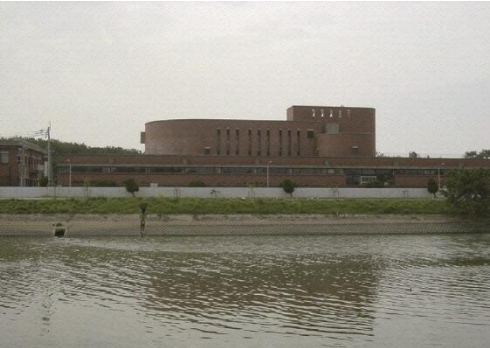
古賀水再生センター
