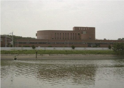
古賀水再生センター
