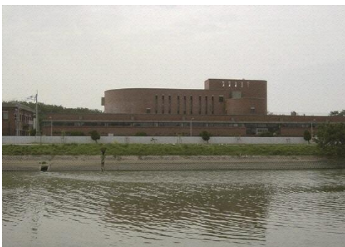
古賀水再生センター
