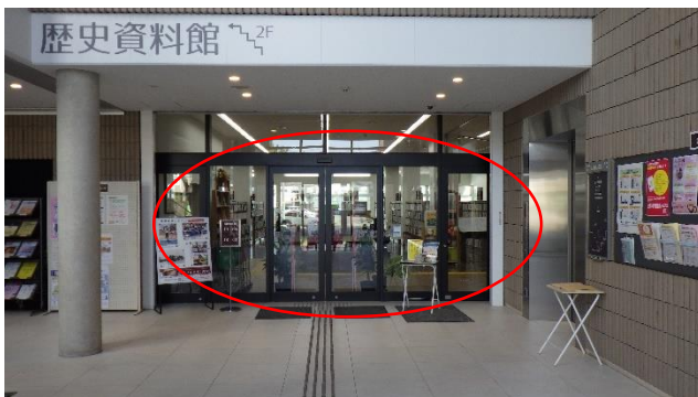
※9:「自動扉枠」の塗装
