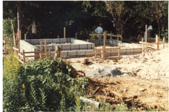
第1回移転工事敷地内整地工事状況
