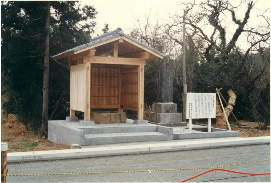
第 1 回移転工事竣工状況 1
