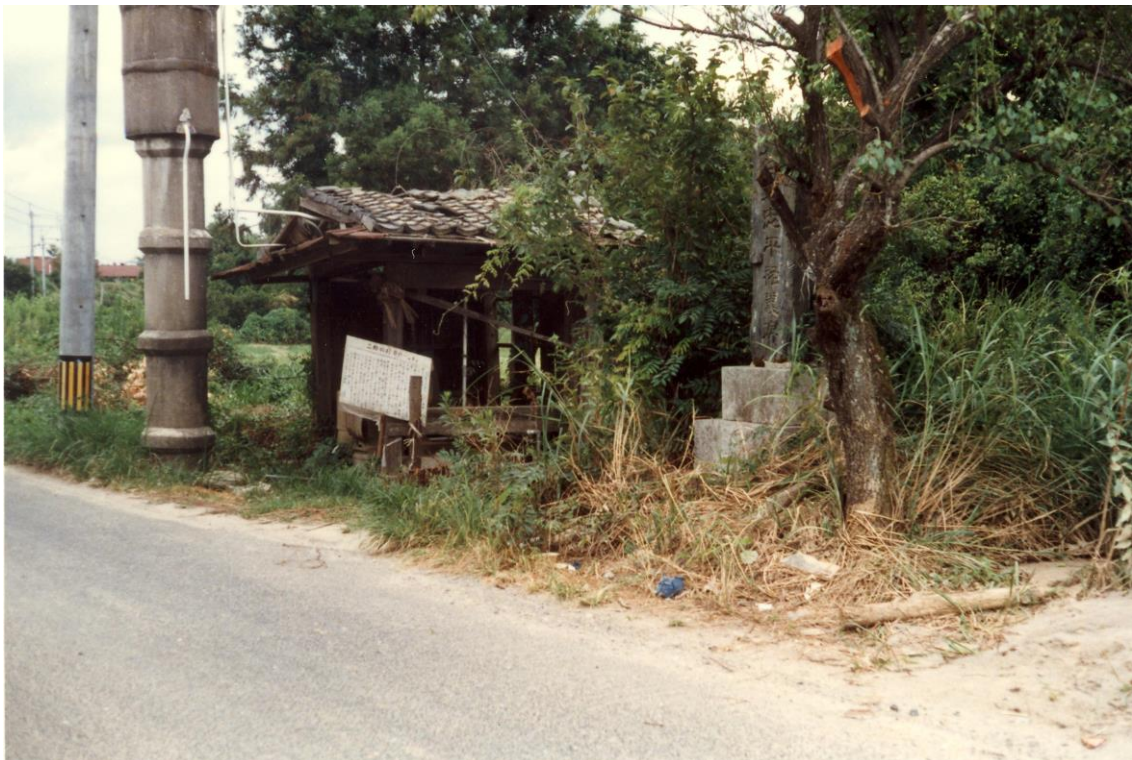
第 1 回移転工事前井戸状況（内殿村側から）
