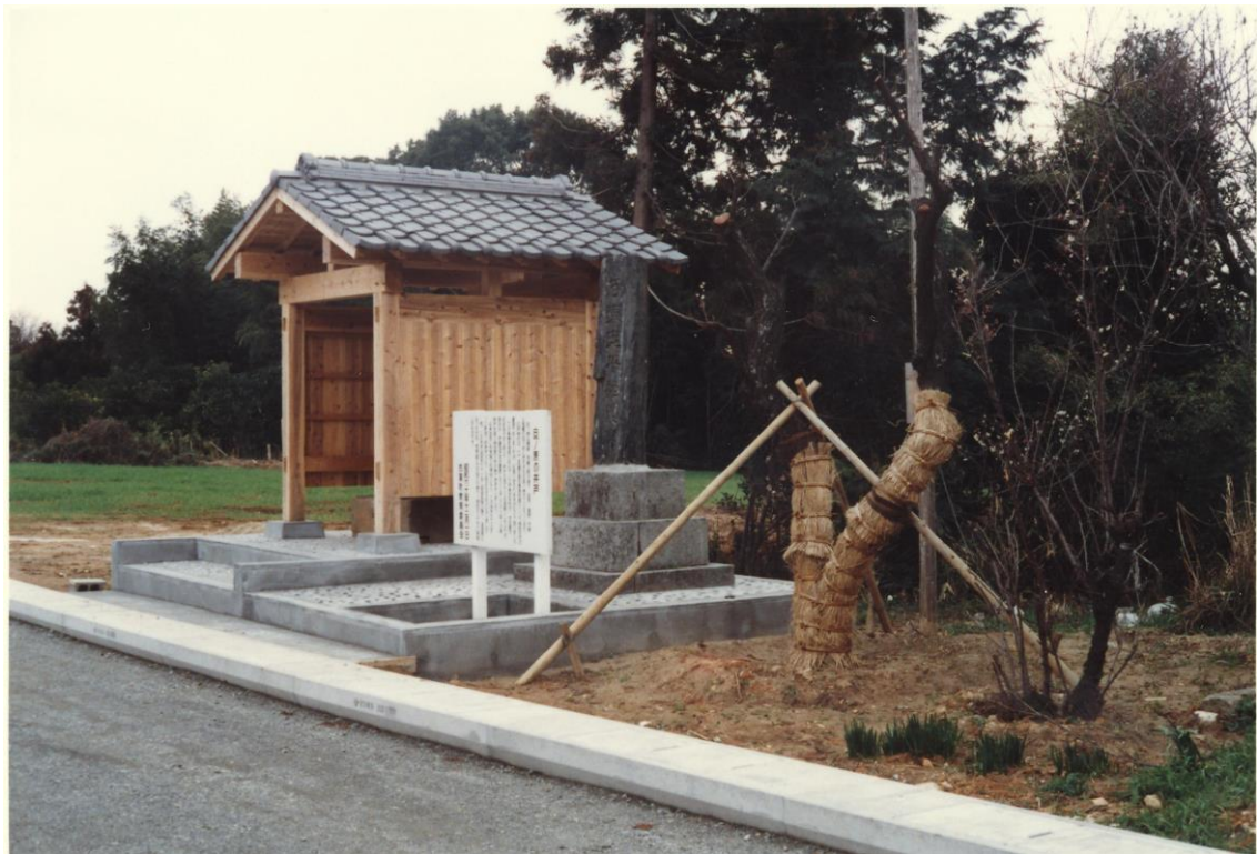
第 1 回移転工事竣工状況 2
