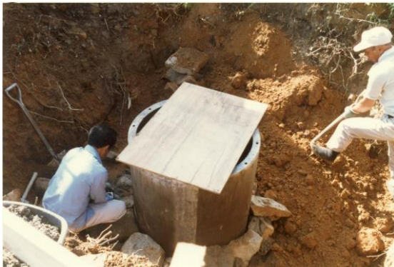
第1回移転工事井戸復元工事状況
