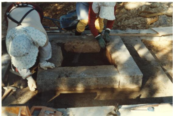
第1回移転工事顕彰碑組立状況1
