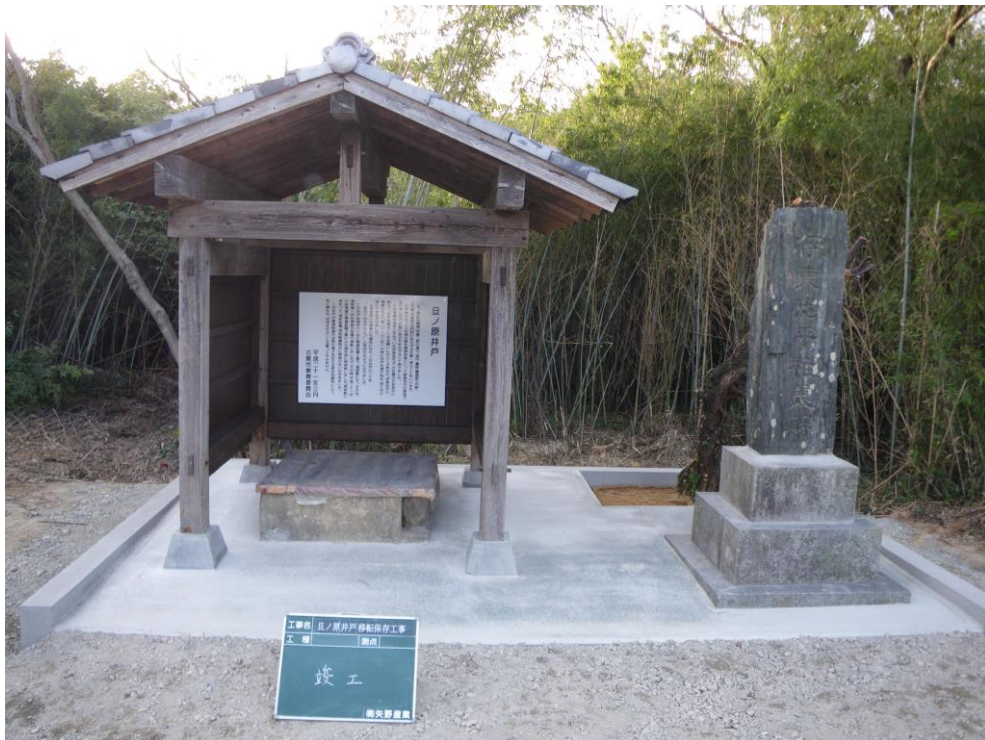
第2回移転工事竣工状況
