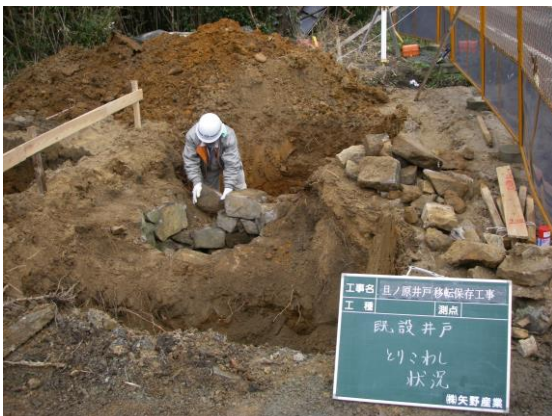
第2回移転工事井戸解体作業
