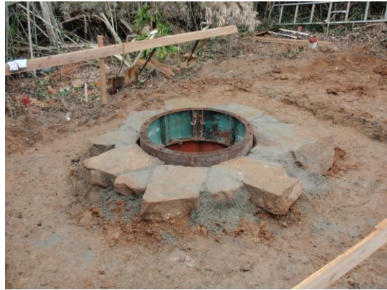
第2回移転工事井戸復元工事2
