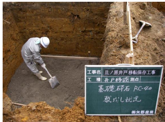
第2回移転工事井戸基礎工事
