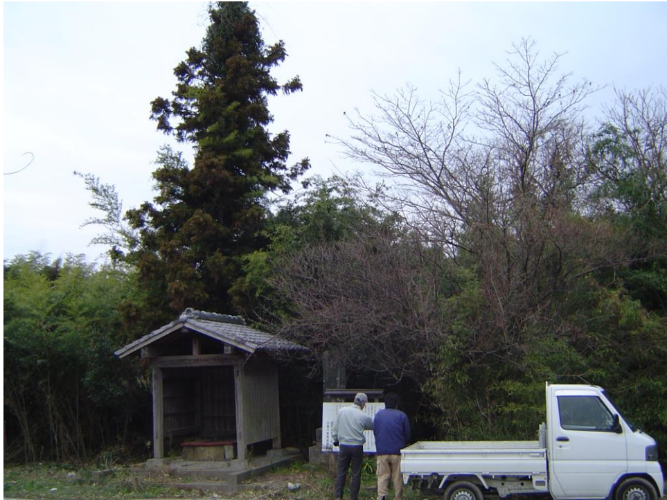
第2回移転工事前井戸状況
