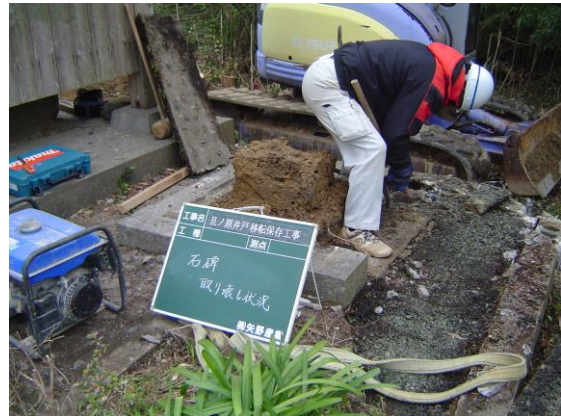
第2回移転工事顕彰碑解体作業2
