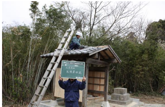
第2回移転工事覆屋組立工事
