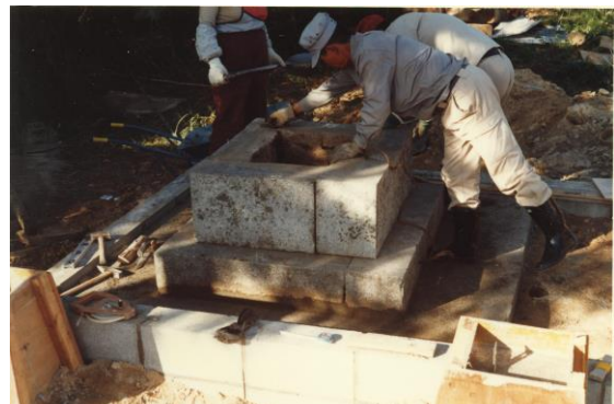
第1回移転工事顕彰碑組立状況2
