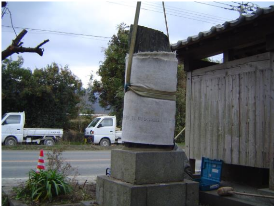
第2回移転工事顕彰碑解体作業1
