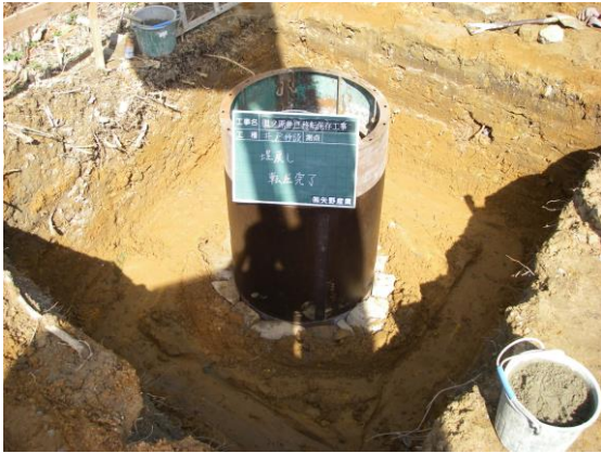
第2回移転工事井戸組立工事1
