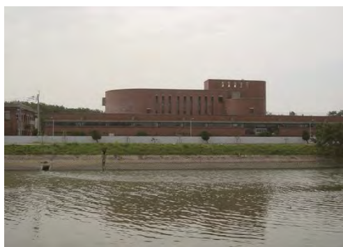
古賀水再生センター
