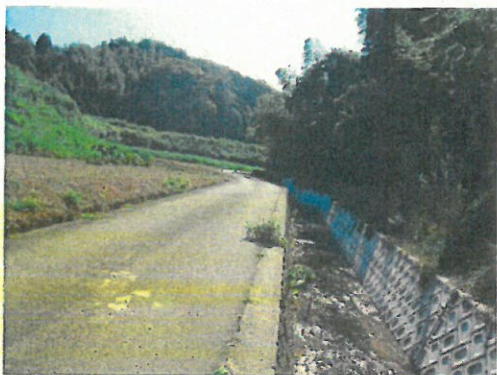
平成27・28年改良 筵内浦田水路
