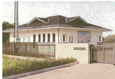
小山田甕水センター
