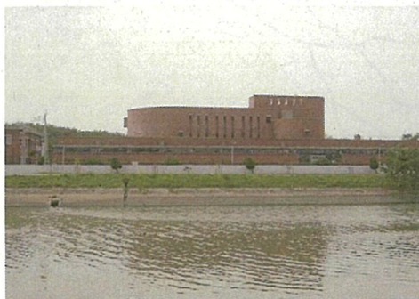
古賀水再生センター
