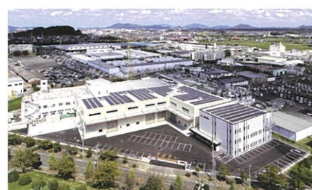
古賀市に開設した新製作所。省エネ設計に加えて消費エネルギーを太陽光でまかなう等でZEB認証も取得している。
