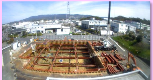
げだんきりばりせつちちゅう 下段切梁設置中 2022.04.01
