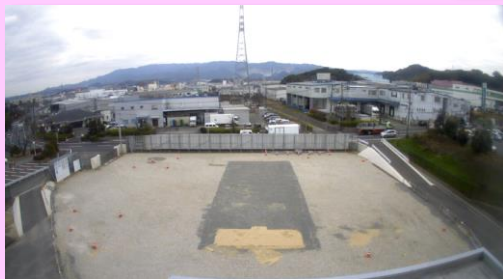
けんせつよていち 建設予定地 2021.12.28
