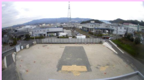
けんせつ よていち 建設予定地 2021.12.28
