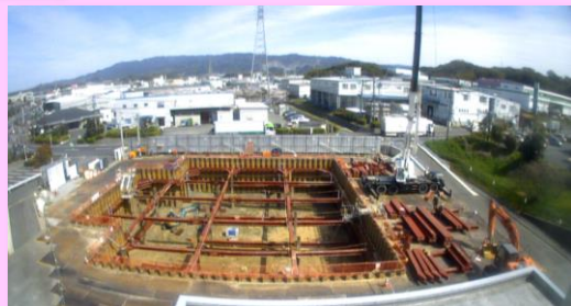
げだんきりばりせつちちゅう 下段切梁設置中 2022.04.01
