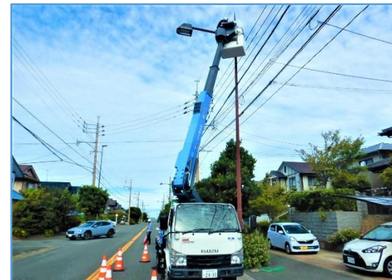
道路照明灯 点検の様子
