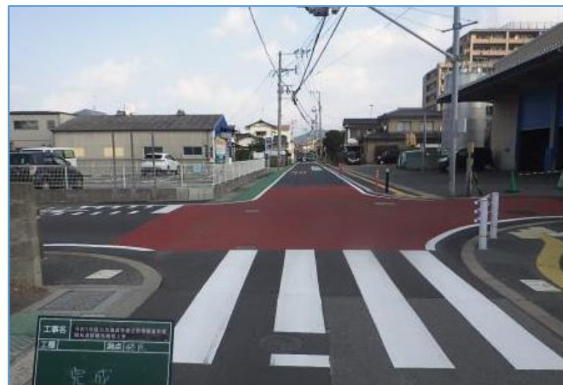
道路舗装補修工事（完了）
