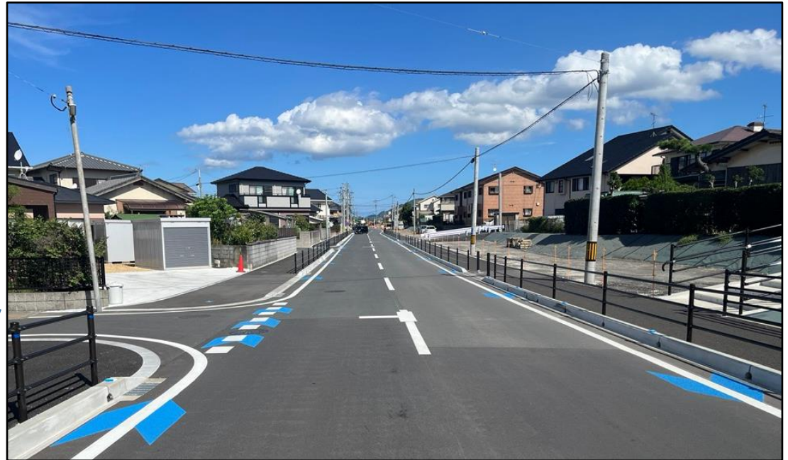
整備が完了した西鉄跡地
