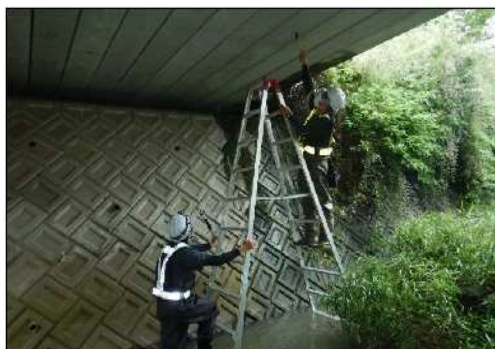
〔脚立による定期点検状況〕
