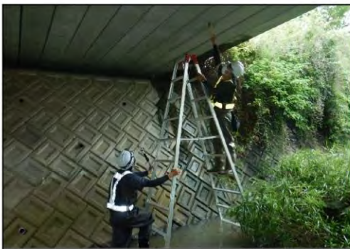
[ 脚立による定期点検状況 ]
