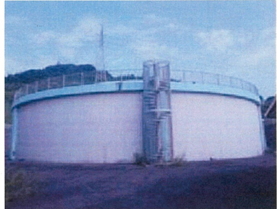
立花第2配水池
