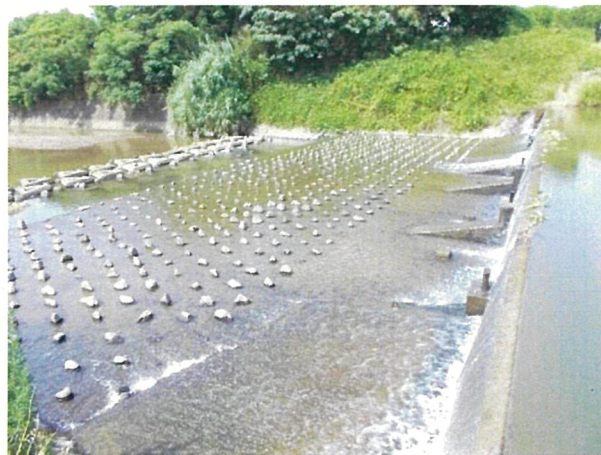
【大根川取水堰】
