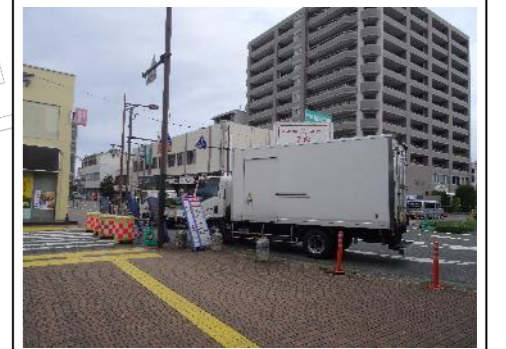
⑩駅前ロータリー 搬入車の確認及び通行許可申請を行っていたものの、搬入車がロータリーに長時間停車し、バス運行等に影響
