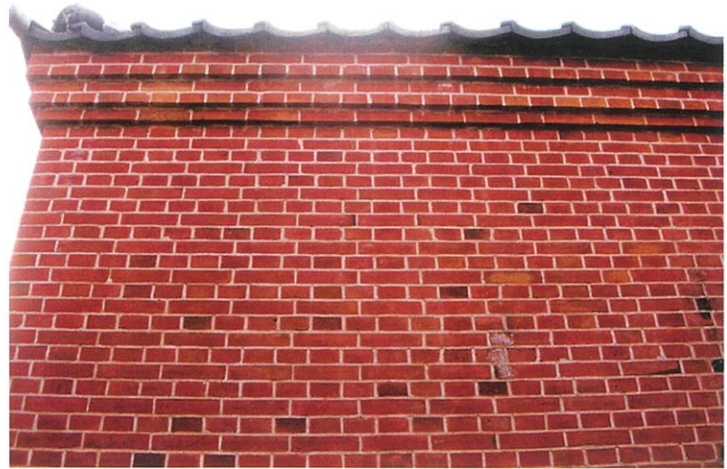
青柳登記所の煉瓦積み(イギリス積み)
