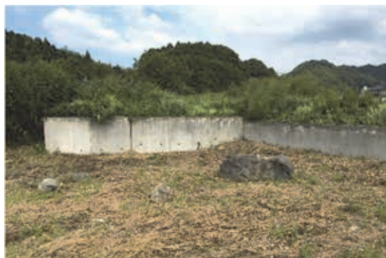
写真 4-13 コンクリート擁壁 2
