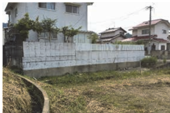
写真 4-14 コンクリート擁壁 3
