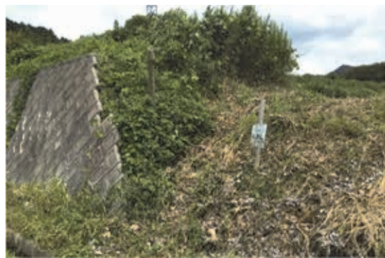
写真 4-12 コンクリート擁壁 1
