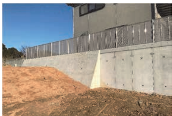
写真 4-15 コンクリート擁壁 4
