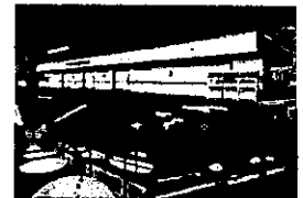
集出荷・貯蔵・加工施設
