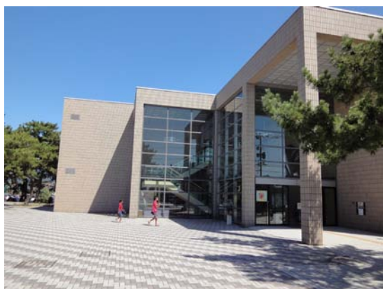
分節化による建物壁面の変化
