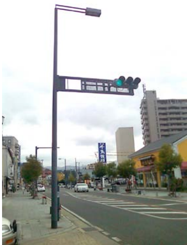
街灯と信号機が一体化した シンプルな構造のデザイン
