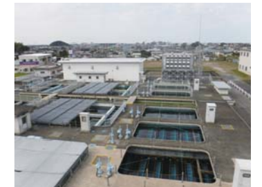
② 古賀市浄水場
