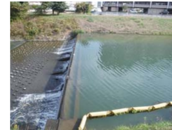
① 大根川(取水堰)
