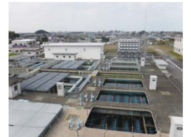
②古賀市浄水場
