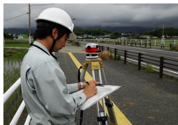
現地で道路の測量も行います
