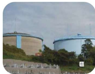
医王寺配水池
