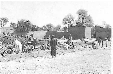
ペシャワールで建設中の新病院。来年の4月に完成する予定です。
