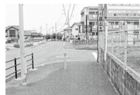
着工前(2019年)の国道495号の様子
