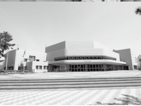
写真上/計画に基づいてコンビニエンスストアに様変わりした旧コミュニティホール。市政情報の発信場所としての機能は維持している。写真下/市の公共施設も、抜本的に運営のあり方を検討することとなった。
