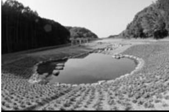
施設の老朽化が心配されていた河内池の整備と市民に水とふれあえる空間を提供することを目的に完成した薬王寺水辺公園
