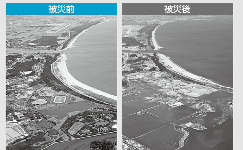
▲東松島市野蒜地区の様子。津波により多くの家屋が流失している上、地盤沈下が生じたため広範囲にわたり海水が浸水していることが分かる。
