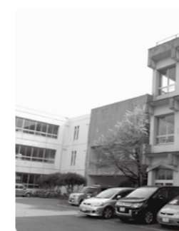
▲大規模工事を行う千鳥小学校
