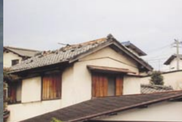
地震で屋根瓦も崩壊。「福岡には地震がない」という安全神話が崩れた瞬間でもありました。
