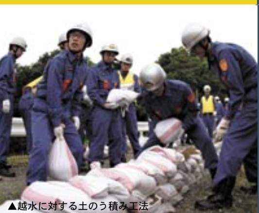
▲越水に対する土のう積み工法
