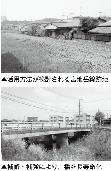
▲活用方法が検討される宮地岳線跡地 ▲補修・補強により、橋を長寿命化
