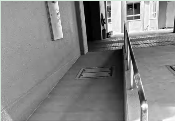
地域開放室入口スロープ
