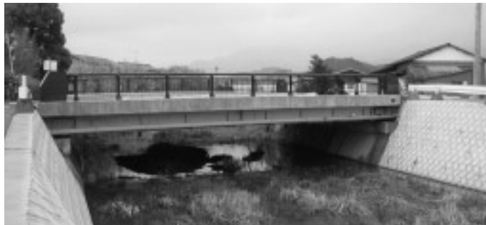
完成した今在家橋
