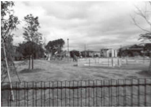
工事が進む花見東地区公園
