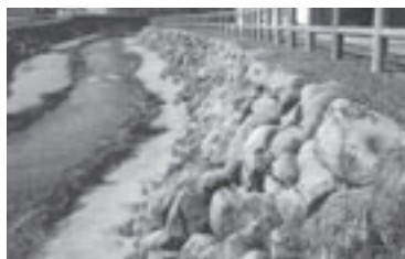
水に親しむ護岸工事例
