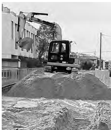
道路の建設が進む宮地岳線跡地 (中川区)
