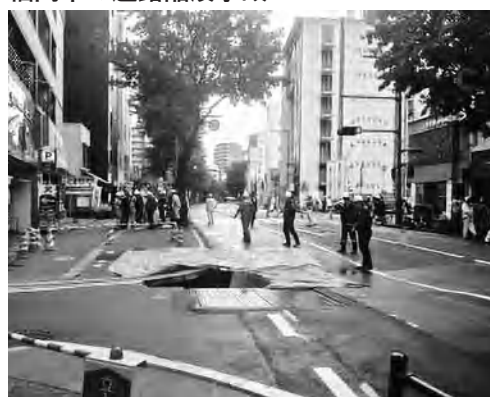
福岡市の道路陥没事故
