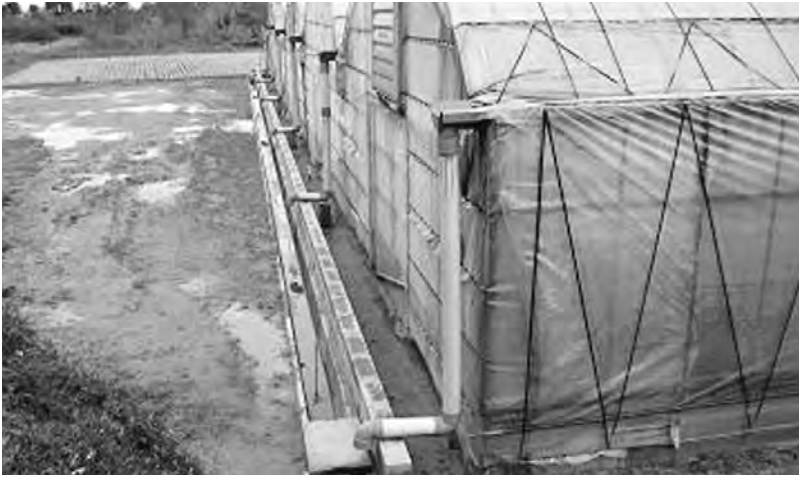
浸水の被害からハウスを守る施設工事
