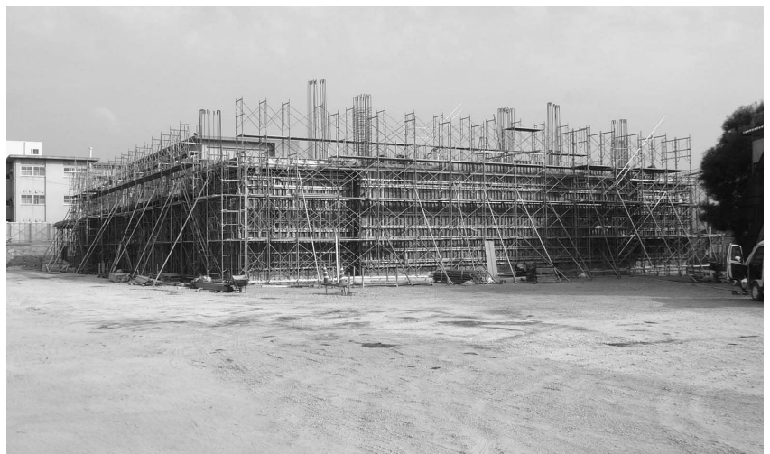
古賀東小体育館の建設現場
