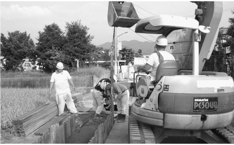
町川原・谷山の集落排水工事現場
