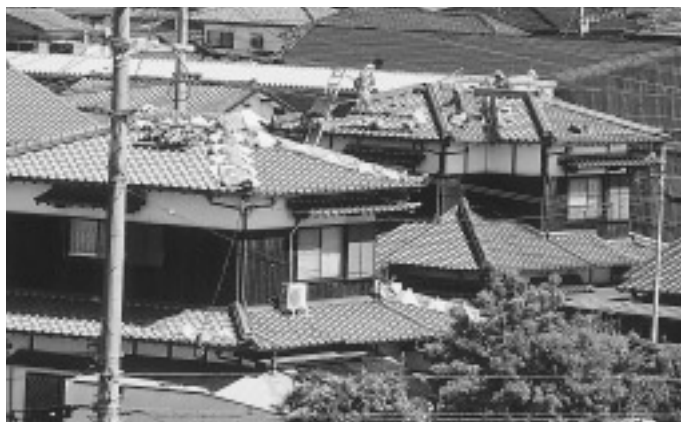
地震による家屋被害
