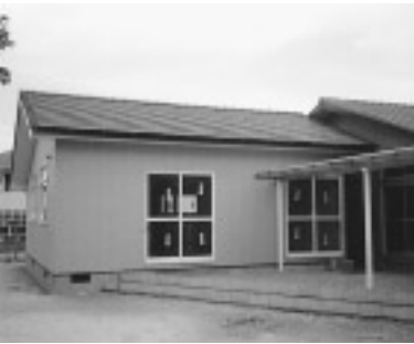
新築された五楽保育所保育室
