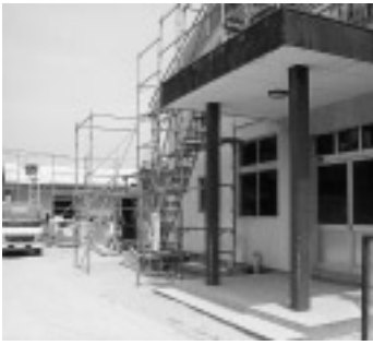
改修工事が進む五楽保育所
