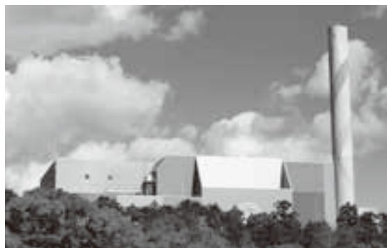
操業12年経過した古賀清掃工場
