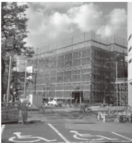
建設が進む生涯学習センター
