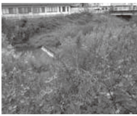
古賀市の危険箇所
