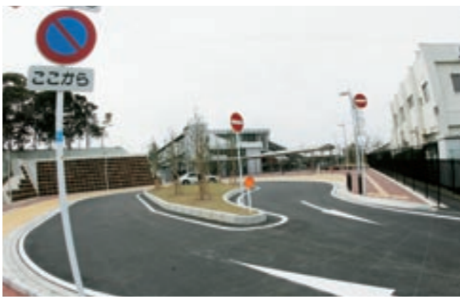
3月14日からの営業開始に合わせ、ししぶ新駅では西側・東側の駅前広場も整備、西鉄バス（東側）や市内循環ミニバス（西側）などの運行や、自家用車などでの送迎に便利なロータリーなども兼ね備え、乗降客の増大が大いに期待されています（写真は同駅西口側）。
