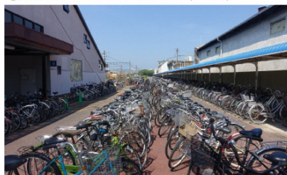
②景観的配慮の無い屋外駐輪場(東口)
