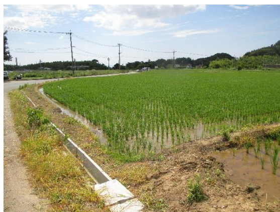
平成30年度 薦野中原水路改良工事
