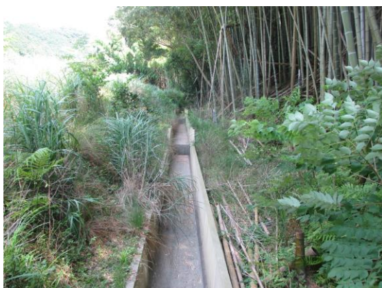
平成30年度 小山田寺浦水路改良工事
