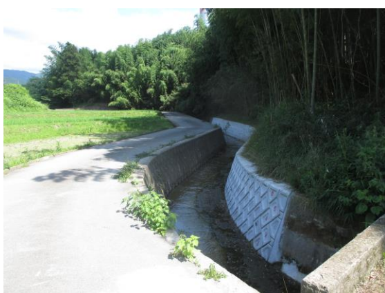
令和2年度 筵内浦田水路改良工事
