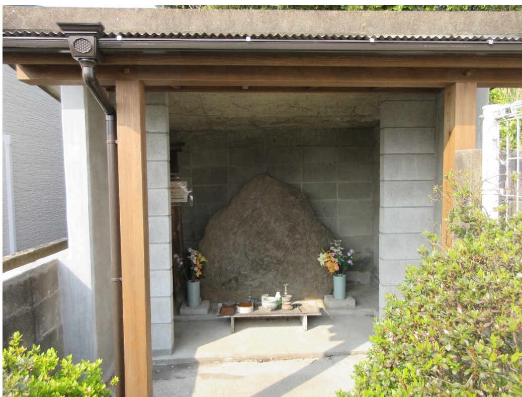
クリーニング・亀裂充填・基質強化後（9月中に撥水処理を実施）
