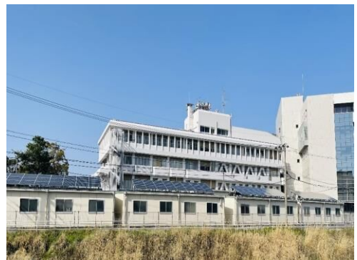
図 3-9 市役所太陽光発電設備
